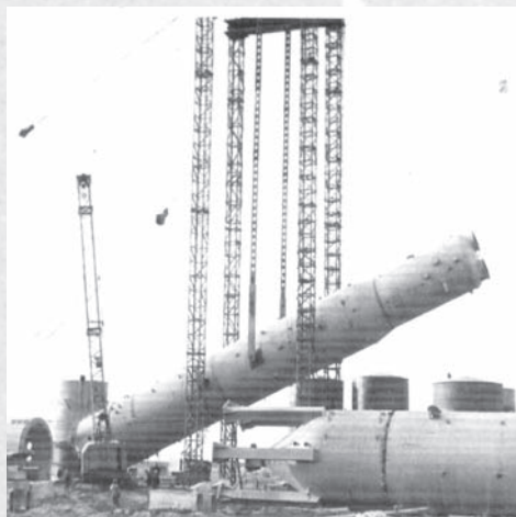
Установка варочных котлов. Середина 1960-х гг.
