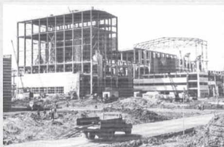
На строительстве главного корпуса СППК.
