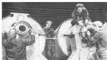
Монтажники на сборке цилиндров сушильной машины. Начало 1970-х гг.
